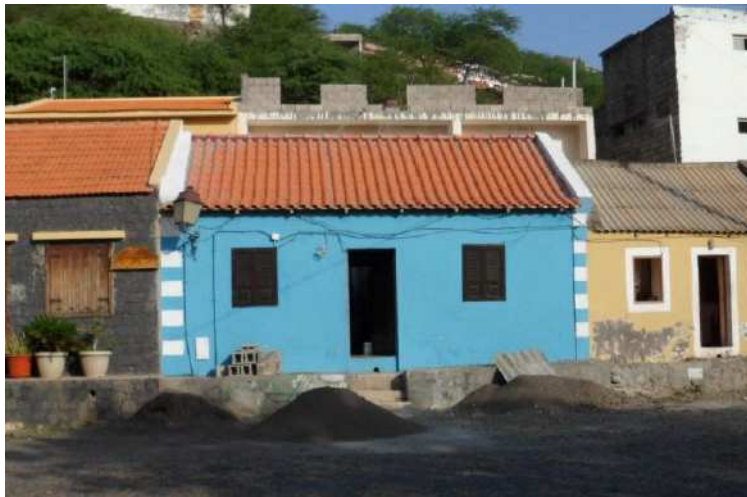
Figura 2.2: Casas vernaculares com cobertura de telha cerâmica, Cidade Velha [31]
