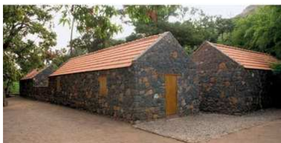
Figura 3.7: Pousada Projetada por Álvaro Siza na cidade Velha, ilha do Santiago [34]
