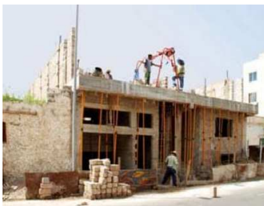
Figura 3.6: Edifício residencial construída na ilha de São Vicente [34]
