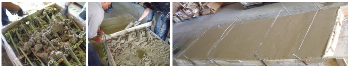
Figura 5.18 Processo de enchimento com argamassa da laje L3.
