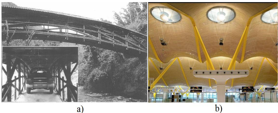
Figura 2.5 a) - ponte em arco com bambu essencialmente a compressão, construído por Jorg Stamm na Colômbia. A ponte tem 40m de vão e é baseado nas pontes de madeira construídas no séc. XVII na Europa; b) - vista da cobertura em bambu do aeroporto de Madrid.
