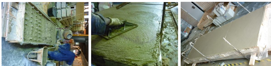
Figura 5.10 Processo de enchimento da laje L2 com argamassa.
