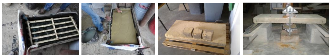
Figura 5.1 Diversas fases de construção da laje de teste e preparação do ensaio.
