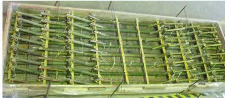
Figura 5.17 Armadura da laje L3 colocada no interior da cofragem, pronta a receber argamassa.
