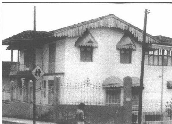
Figura 3.26 (Hidalgo-López 2003) casa construída no século XIX em Manizales-Colômbia, com mais de 112 anos e em bom estado devido a boa manutenção.
