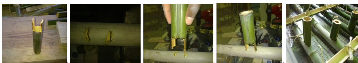
Figura 5.8 Produção de armaduras para a laje L2.
