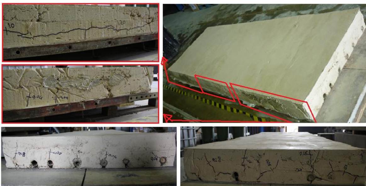
Figura 5.19 Levantamento das fissuras ocorridas no processo de cura da laje L3.
