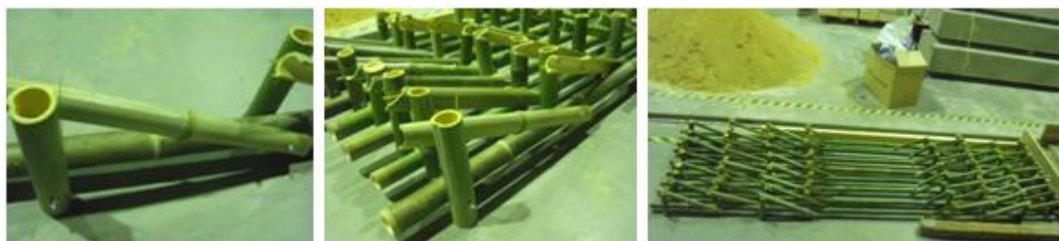
Figura 5.16 Produção de armadura para a laje L3.
