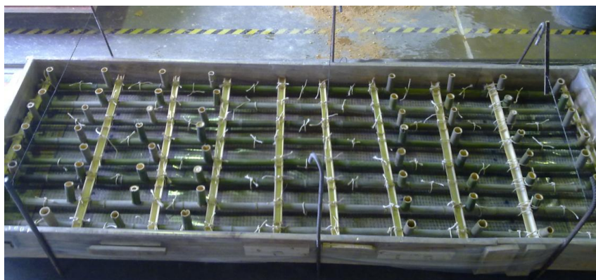
Figura 5.9 Armadura da laje L2 colocada no interior da cofragem, pronta a receber argamassa.
