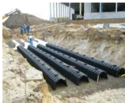
Figura 12 - d) Aplicação de Tuneis de drenagem Fonte: http://www.graf-water.com/
