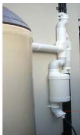
Figura 74 – b) Sistema First Flush para tanques exteriores Fonte: ( http://www.raindog.com.au )
