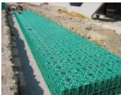
Figura 12 - c) Aplicação de Stormboxes Fonte: ( http://www.pipelife.com )
