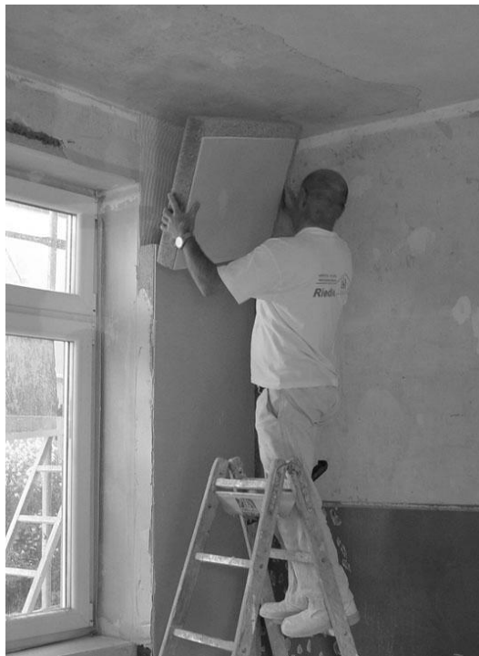
Figura 76 - Filtros acústicos do tipo "sanduíche" (Leão, 2011)
