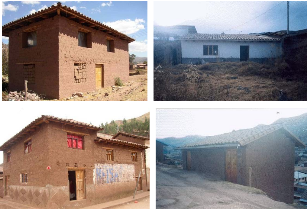
Figura 3. Viviendas rurales de tierra en Cusco (Blondet et al. , 2004).
