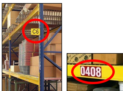
Figura 39: Painéis de identificação e porta-etiquetas.
