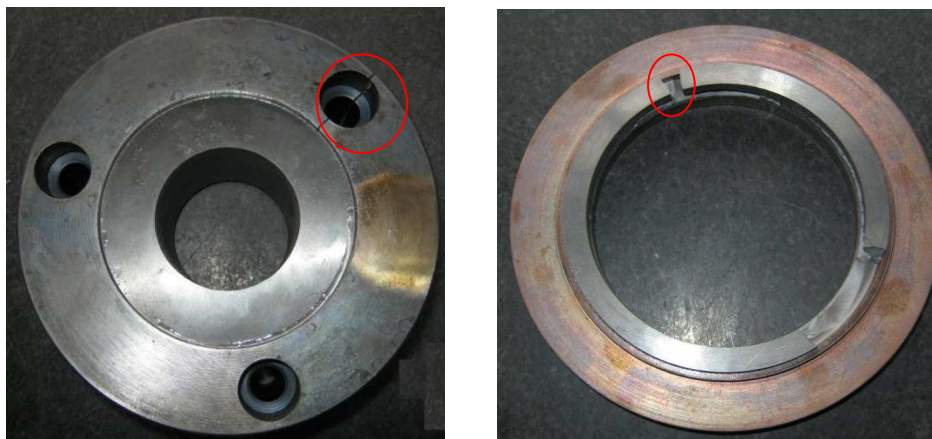
Figura 18 – a) Matriz fissurada na carcaça de aço devido a aperto excessivo; b) Matriz fissurada no núcleo de MD devido a aperto excessivo
