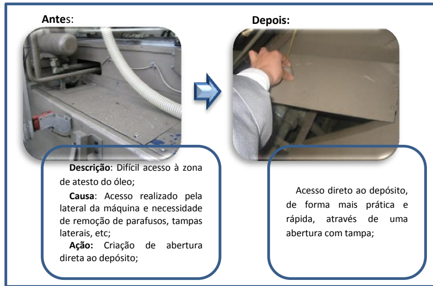
Figura 26 - Situação de difícil acesso ao depósito do óleo
