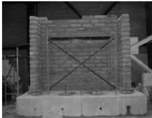
Figura 1b. Fase final da construção da parede (antes do reboco)
