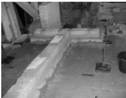
Figura 1a. Construção da parede de alvenaria de adobe. Início da construção (primeiras fiadas)
