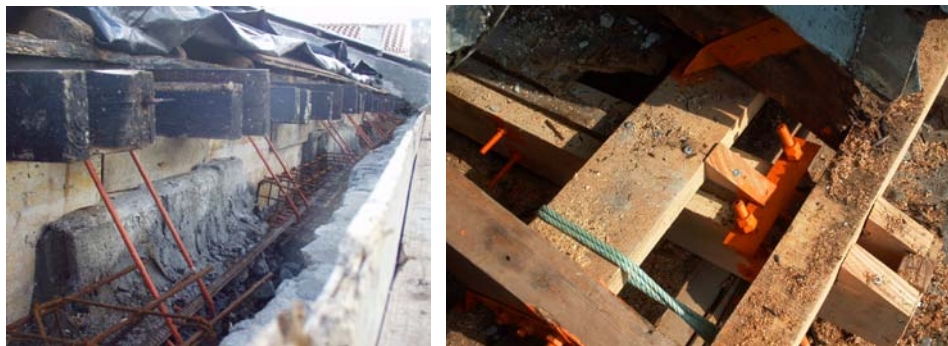
Figura 1: Aplicação da cinta de coroamento em obra [5]
