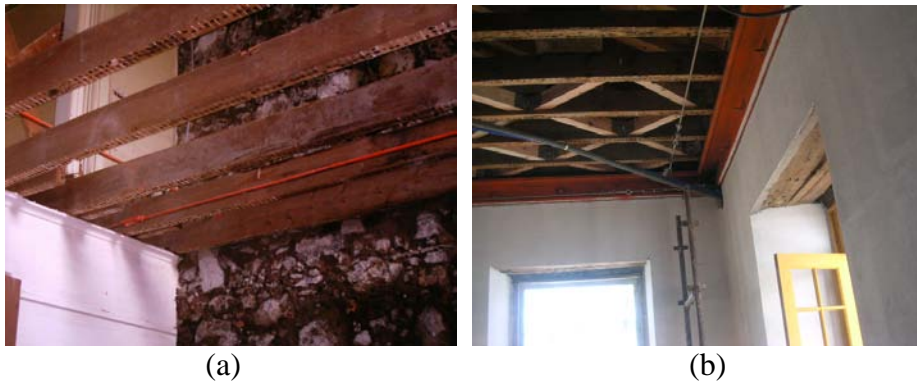
Figura 5: Tirantes: (a) Varões, (b) Cabos [5]
