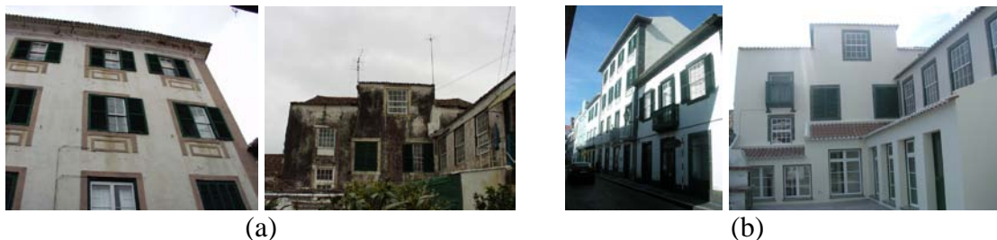
Figura 9: Edifício do caso de estudo: (a) Antes do reforço sísmico (b) Após reforço sísmico [5]
