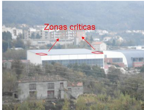
Fig. 3: Zonas críticas da cobertura do corpo 1
