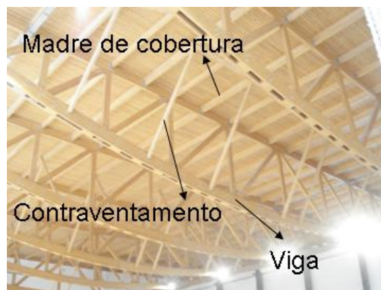
Fig. 2: Elementos estruturais de madeira da cobertura do corpo 1
