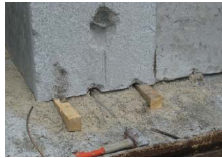
Figura 16. Utilização de cunhas e esmagamento consequente.
