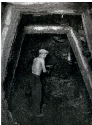
Fig. 39: Desmonte de uma galeria, 1921 (Museu Mineiro, s.d.)
