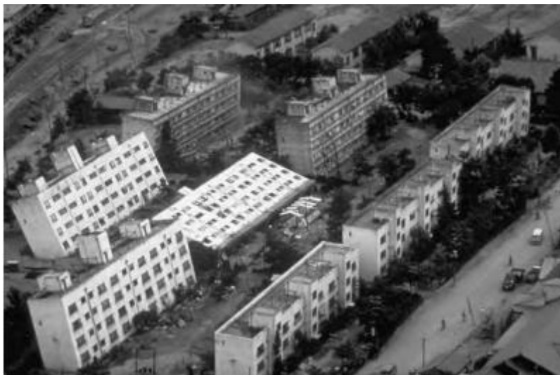
Figura 1- Edifícios em Kawagishi-cho, Niigata, Japão
