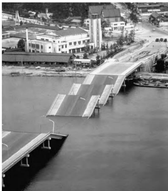
Figura 2- Colapso de uma ponte, causado pela liquefação durante 1964 em Niigata
