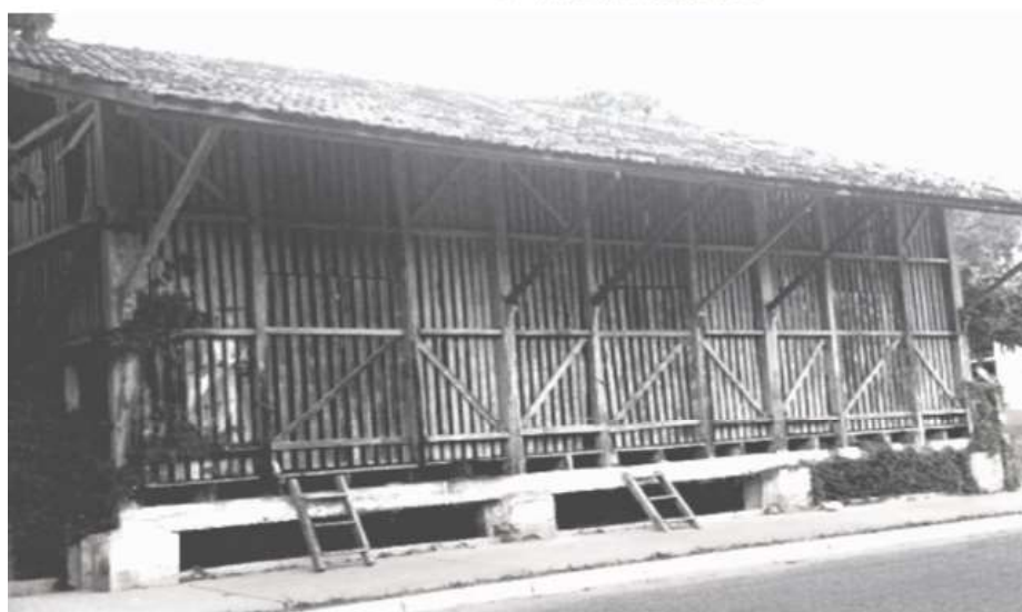
Figura 11. Paiol alvenaria (tijolo) e madeira. Ao lado, paiol constituído de 4 pilastras de alvenaria de tijolos; pilastras e pés direitos de madeira; cobertura de telha tipo francesa e piso de terra comprimida entre paredes de alvenaria. Fonte: [7].
