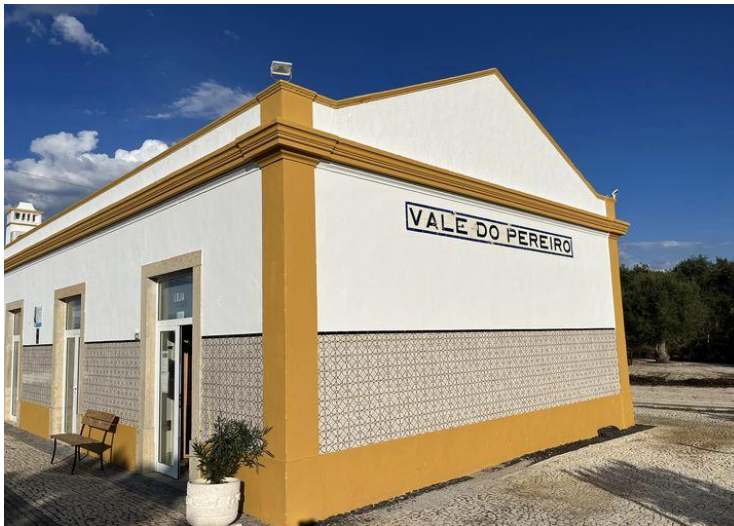
Antiga Estação de Caminho de Ferro de Vale do Pereiro (Recuperada)
