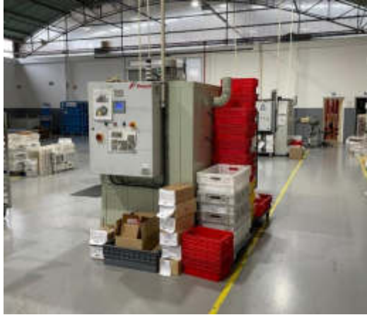
Figura 26 - Área b) destinada ao quadro das amostras de crencos (antes)
