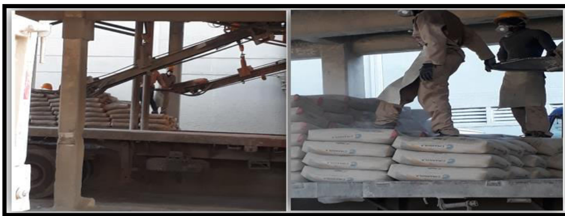
Figura 6.1. Carregamento manual do cimento na Nova Cimangola. Fonte: o autor.
