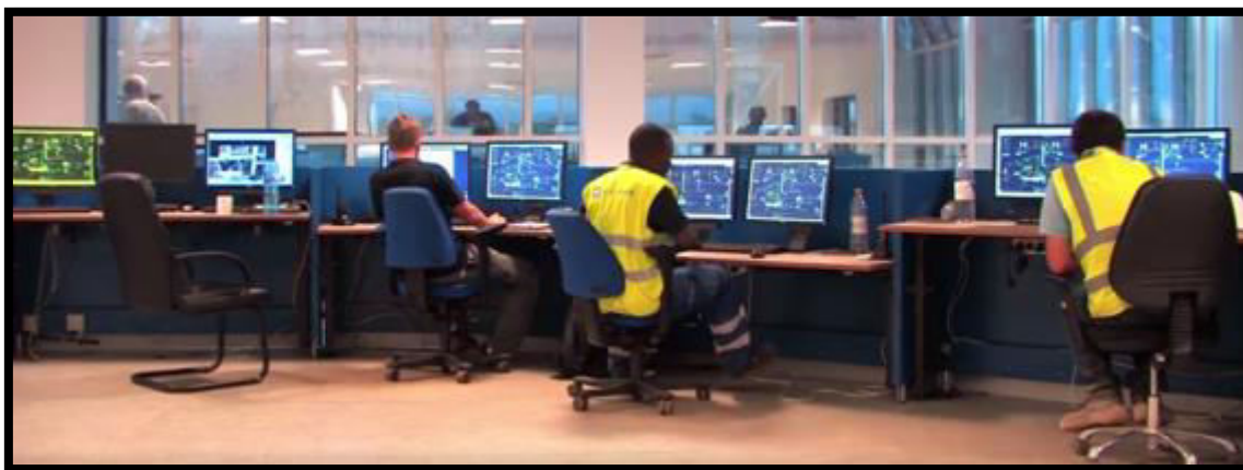
Figura 6.3. Imagem de uma sala de comando (FCKS). Fonte: o autor.
