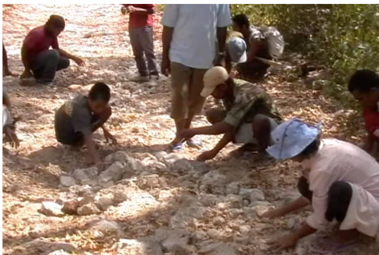
Figura 0. 40 – Construção da estrada pela comunidade
