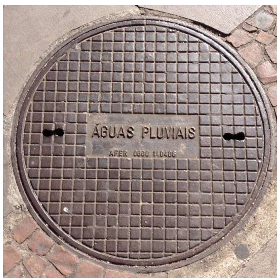
Tampa de uma caixa de visita
