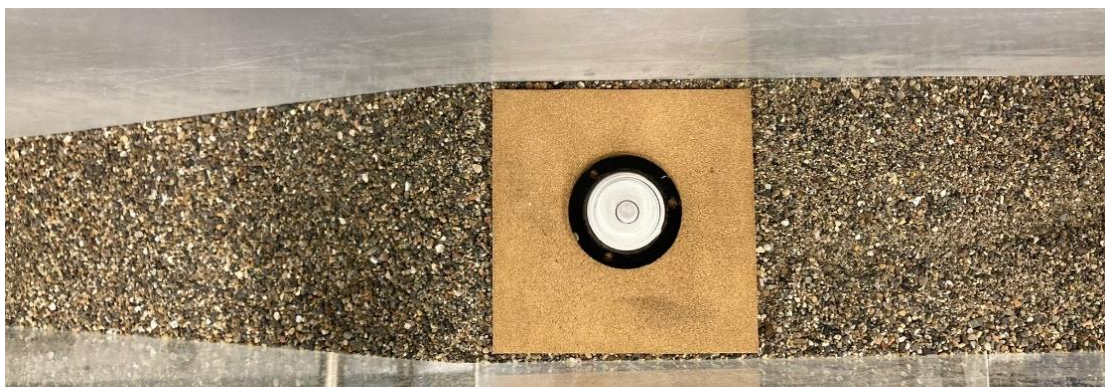
Figura 52. Controlo da horizontalidade do elemento de fundação
