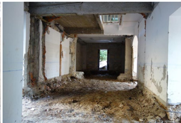
Fig. 4 – Casa Salabert – fundações das paredes de alvenaria
