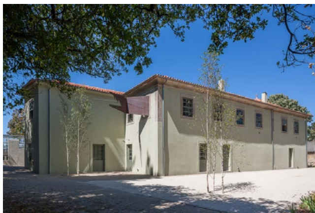
Fig. 5 – Casa Salabert – vista geral da obra acabada
