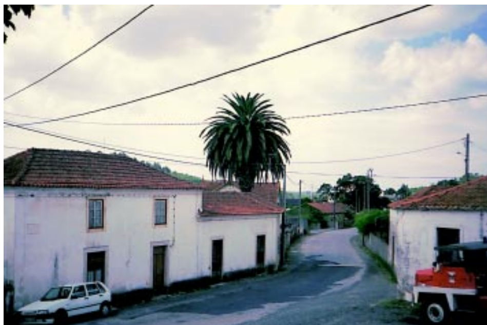
24. Rua Albano Alves Pereira (vista da porta Oeste da Igreja Matriz)
