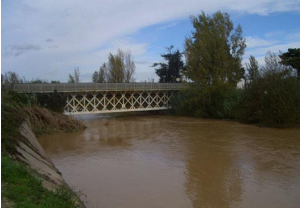
Rio Lis: cheia de 2006 (vista a montante da ponte metálica de Monte Real) Foto: Augusto Mota
