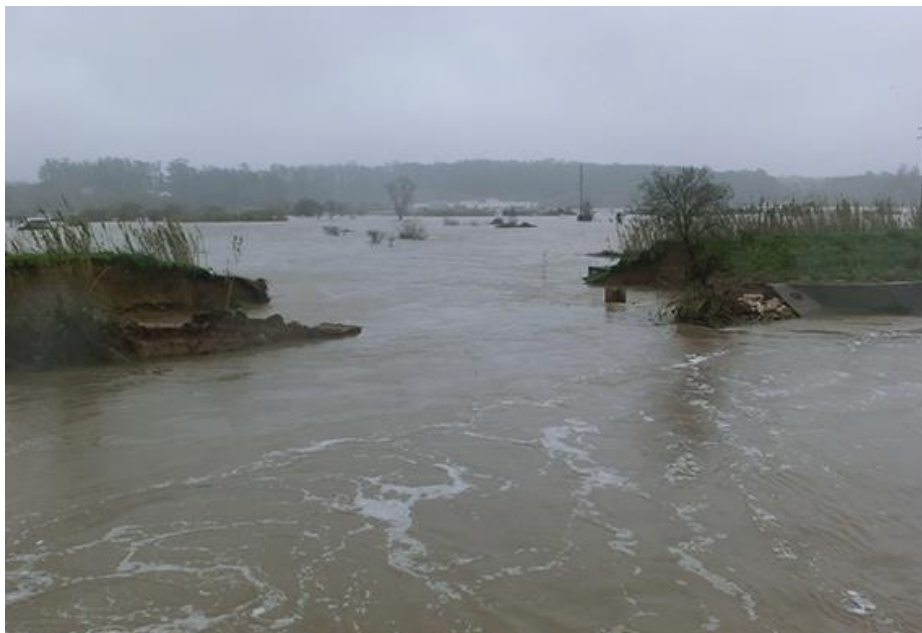
Rio Lis: rombo na margem esquerda em 2014 (junto ao açude insuflável das Salgadas) Foto: Augusto Mota
