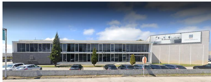
Figura 5 - Sede e Unidade Industrial de Esigueira, Fonte: Aleluia Cerâmicas, S.A.
