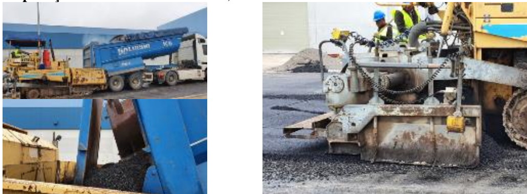
Trabalho de espalhamento através duma pavimentadora de rastros
