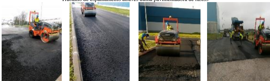
Trabalhos de compactação através dum cilindro tandem
