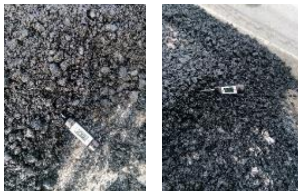
Figura 28. Controlo da temperatura à saída da pavimentadora.
