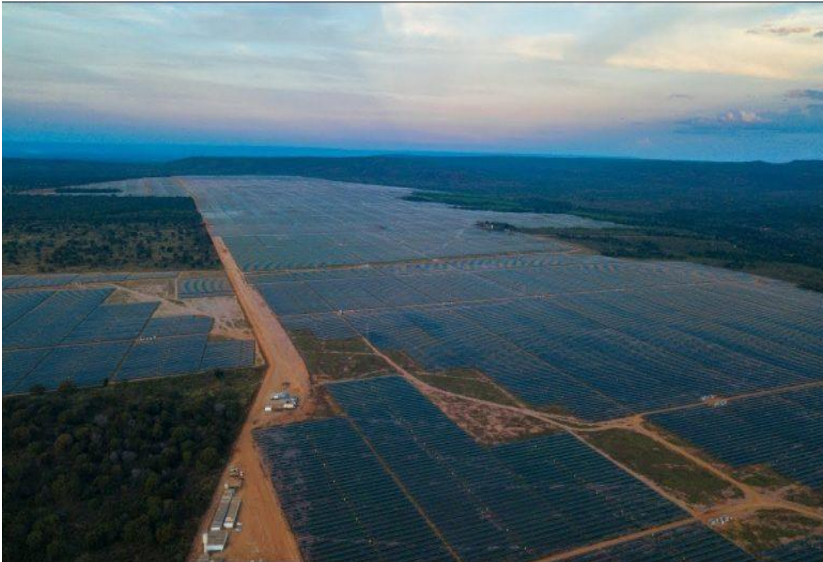
Figura 23: Complexo Solar Pirapora Fonte: Cleuton Andrade, 2020
