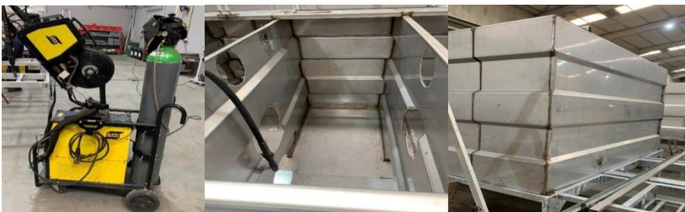
*Figura 25 - Processo de soldadura das chapas, tubagens e respetivos acessórios de forma a concluir a construção dos tanques de água da JMO.*
