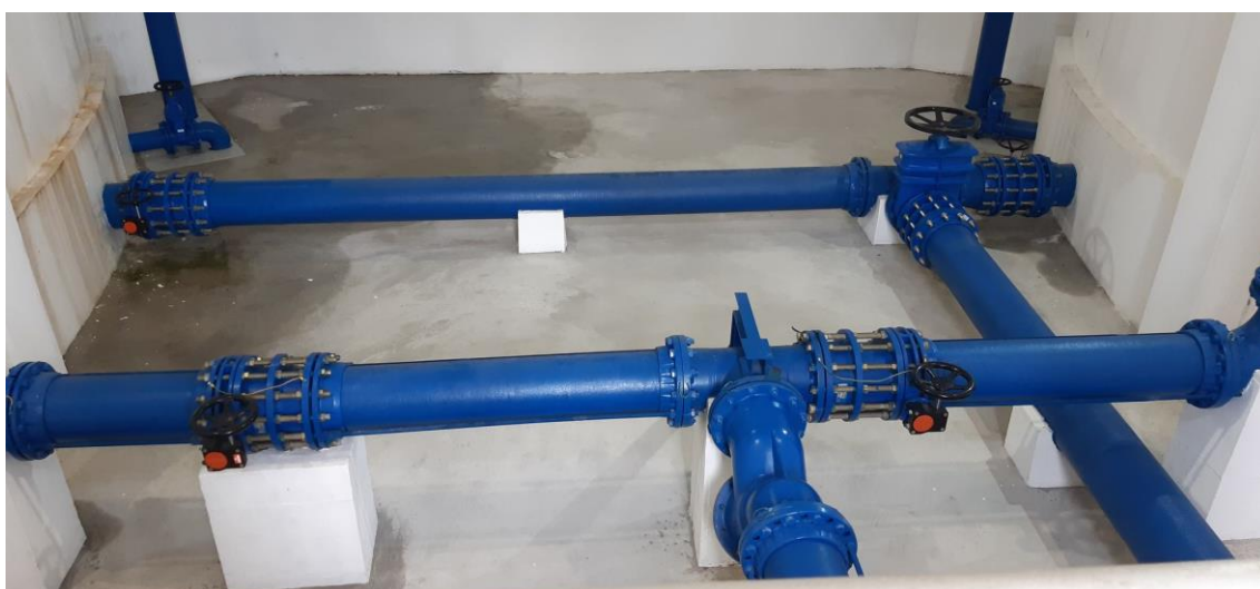
Figura 14: Reservatório do Beco
