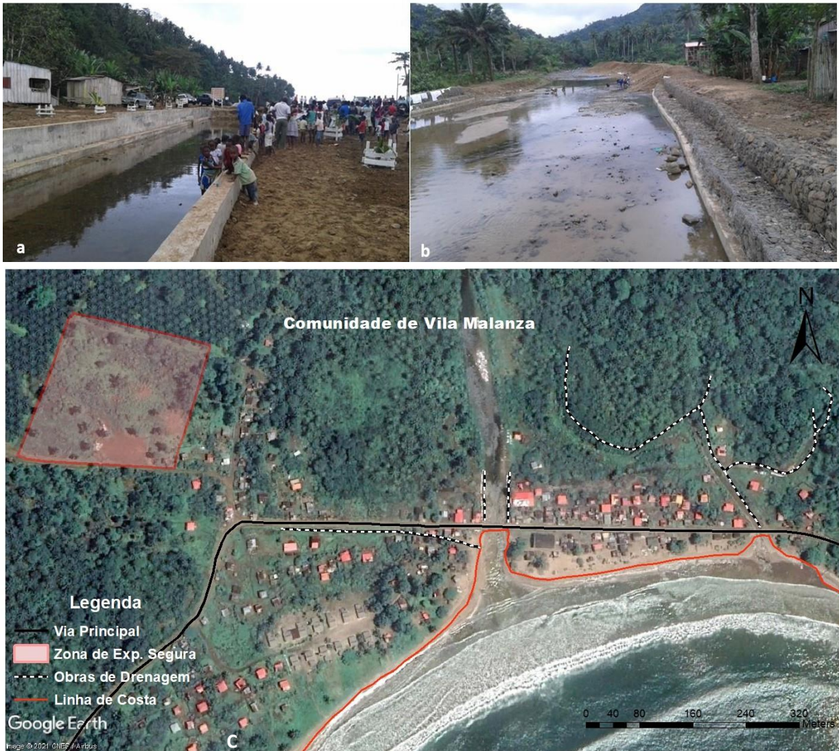
Figura 13 - Obras feitas em Vila Malanza para minimizar as cheias causadas pelo rio Gonbella – (a) – Valas de Drenagens; (b) – Diques. Fonte: Jornal Téla Nón; (c) Mapa de Localização das Obras de Drenagens
