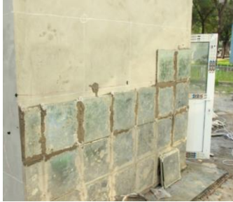
Figura 3.10 PCM macroencapsulado em placas [31].
