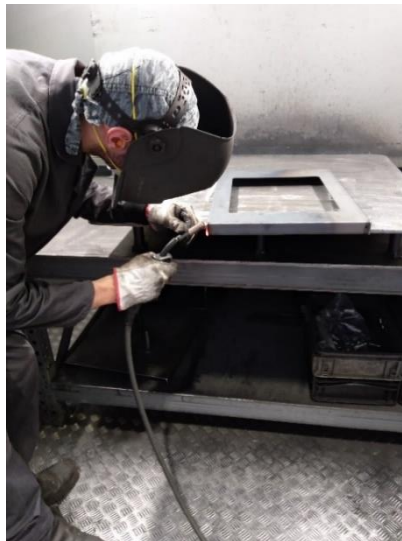
Figura 27 - Fechamento dos cantos da porta com cordão de solda
