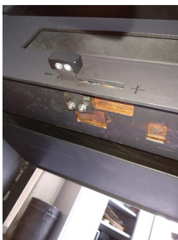
Figura 7 - Posição mínima do manípulo de regulação das entradas de ar. Panadero Vera.
