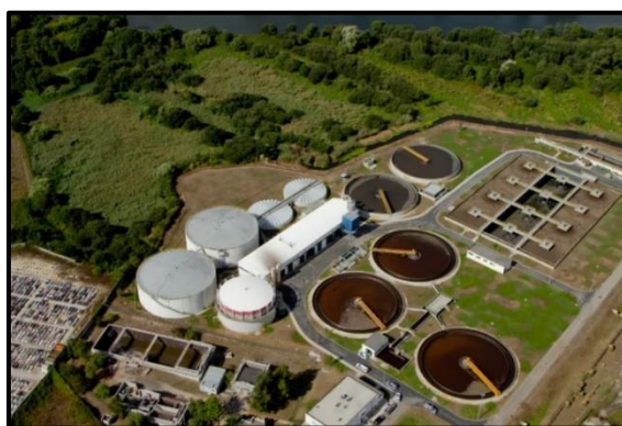
Figura 6 - Vista aérea da ETAR Norte
