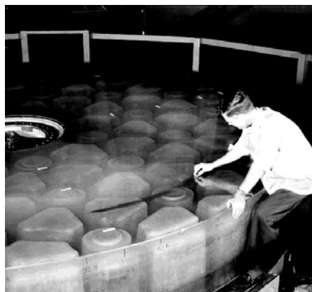
Fig. 80 - Entre 1936 e 1947, o espelho em "pyrex" foi polido e lustrado.
