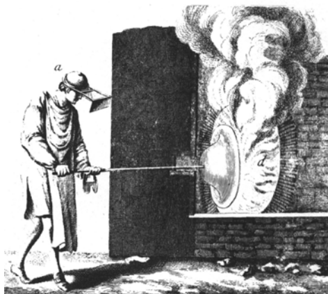
Fig. 81 – Fabricação de vidro pelo método da coroa. Fonte: http://www.maryevans.com
