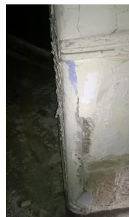
Fig. 1.28 remate da argamassa no tabique
