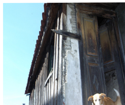
Fig. 1.101 Parede onde se removeu a amostra
