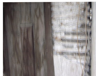
Fig. 1.78 Parede onde se removeu a amostra
