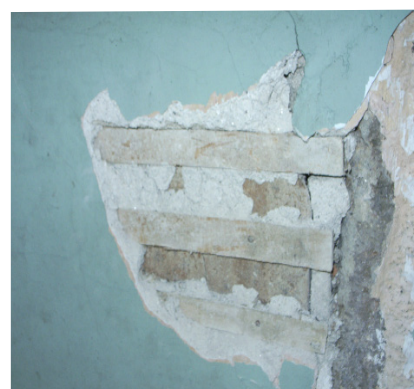
Fig. 1.97 Parede onde se removeu a amostra
