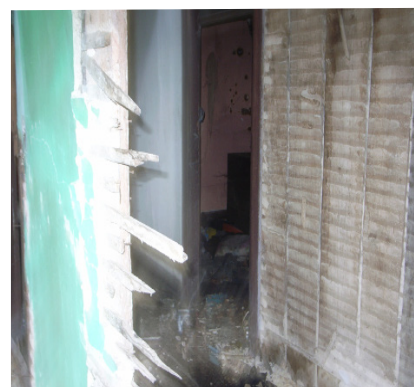
Fig. 1.89 Parede onde se removeu a amostra
