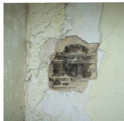
Fig. 1.120 Parede onde se removeu a amostra
