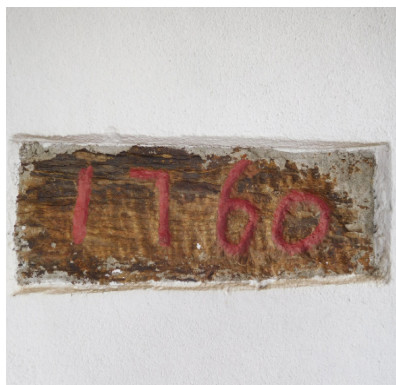
Fig. 1.55 Parede com datação do edifício
