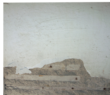
Fig. 1.112 Parede onde se removeu a amostra
