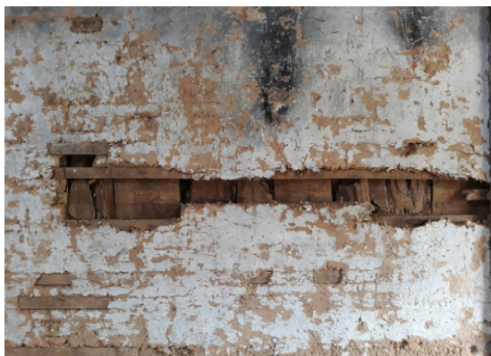
Fig. 1.70 Parede onde se removeu a amostra
