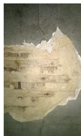
Fig. 1.37 Remoção da camada de emboço
