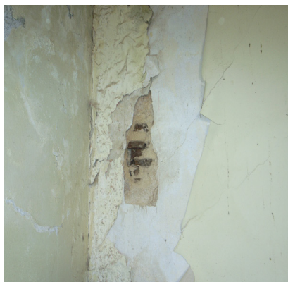
Fig. 1.119 Parede interior do salão de dança
