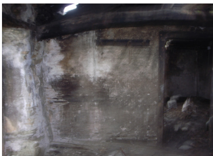
Fig. 1.77 Foto da parede interior
