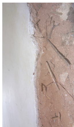
Fig. 1.93 Parede onde se removeu o reboco
