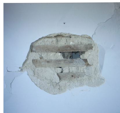
Fig. 1.116 Parede onde se removeu a amostra
