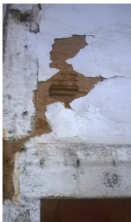
Fig. 1.31 Parede exterior da Habitação – 1ºP
