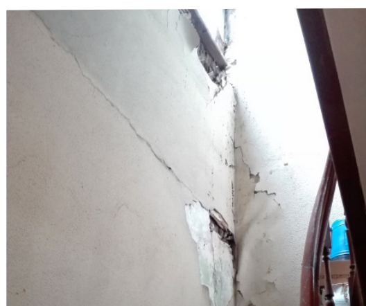
Fig. 1.41 Parede onde foi removida a amostra
