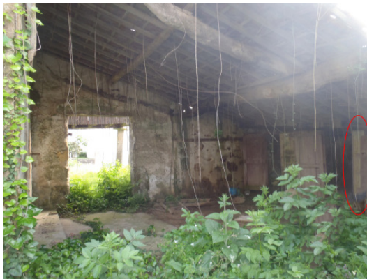
Fig. 1.48 Parede interior onde se removeu a amostra
