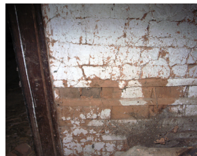
Fig. 1.67 Zona de remoção da amostra, parede interior
