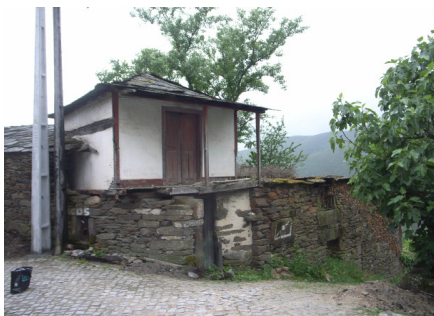
Fig. 1.84 Parede onde se removeu a amostra
