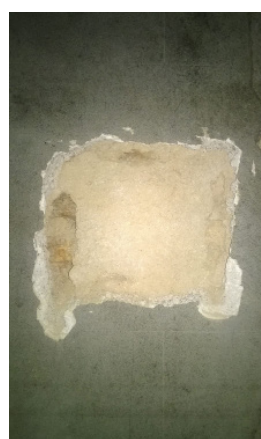
Fig. 1.36 Remoção da camada de reboco
