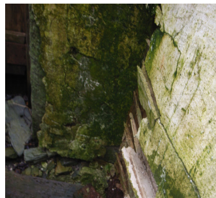
Fig. 1.74 Parede onde se removeu a amostra
