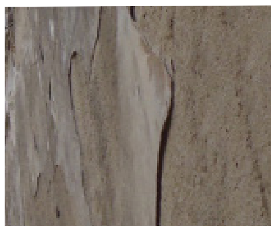
Fig. 1.45 Parede interior se removeu a amostra
