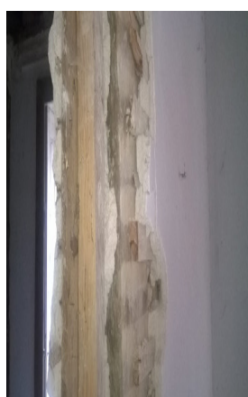
Fig. 1.22 Pormenor da parede
