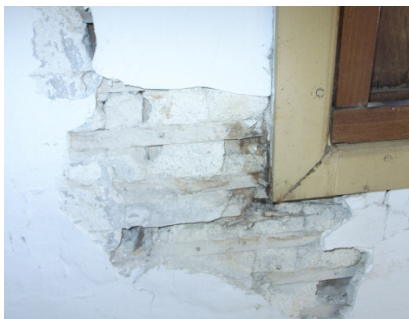
Fig. 1.104 Parede do anexo, vista do interior
