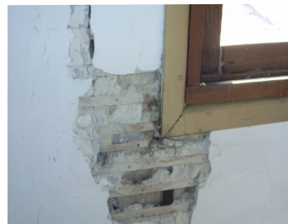
Fig. 1.105 Parede onde se removeu a amostra
