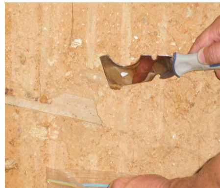
Fig. 1.56 Zona de remoção da amostra, parede interior, r/c
