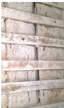
Fig. 1.8 e 1.9 Estruturas do suporte da argamassa de tabique
