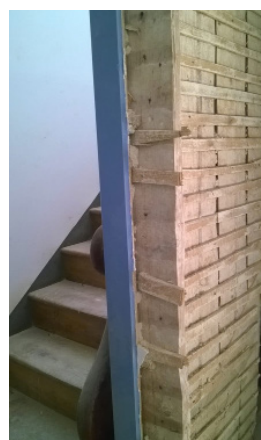
Fig. 1.8 e 1.9 Estruturas do suporte da argamassa de tabique
