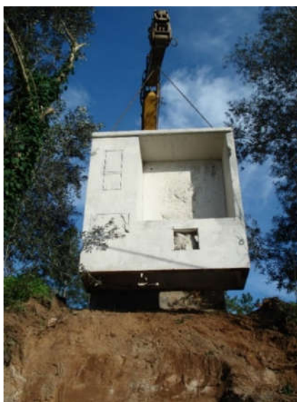
Figura 59 - Instalação de mural para quadro elétrico e contadores
