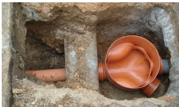
Figura 34 - Pormenor de base de caixa de ramal
