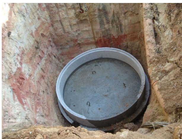
Figura 53 - Colocação de fundo pré-fabricado em betão armado
