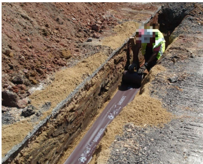
Figura 27 - Colocação de fita sinalizadora com a inscrição "Saneamento"
