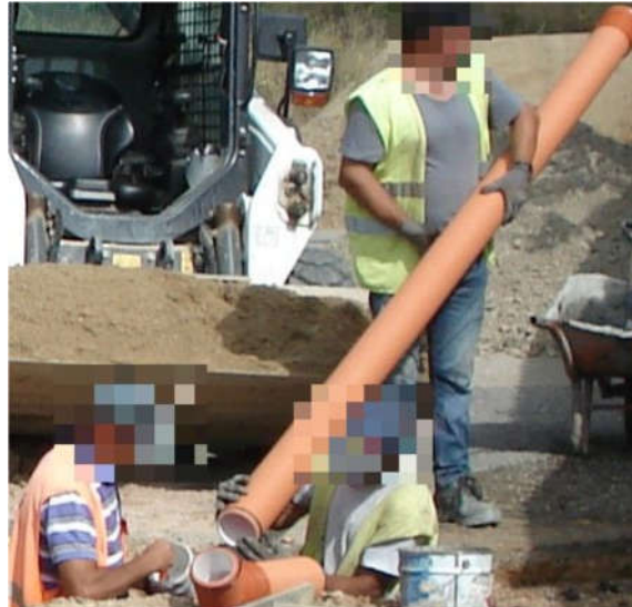
Figura 25 - Colocação de junta de estanquidade e lubrificação da mesma
