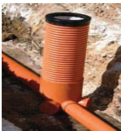
Figura 36 - Caixa de ramal de ligação antes de ser aterrada
