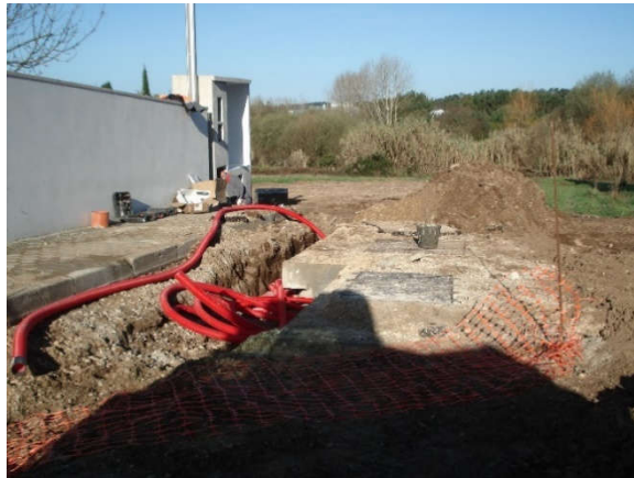
Figura 64 - Instalação de negativos para cabos de ligações elétricas do quadro à estação elevatória
