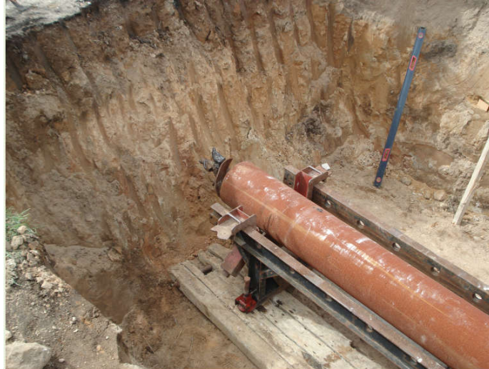
Figura 48 - Colocação da tubagem de encamisamento no equipamento de perfuração
