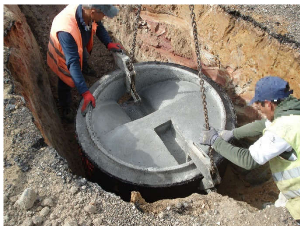
Figura 29 - Movimentação do fundo pré-fabricado em betão da câmara de visita
