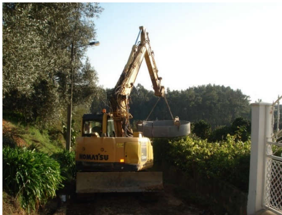
Figura 54 - Colocação de anel pré-fabricado em betão
