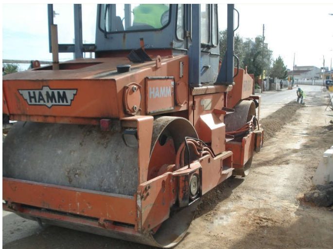
Figura 40 - Compactação de camada de agregado britado de granulometria extensa com recurso a cilindro de rolo
