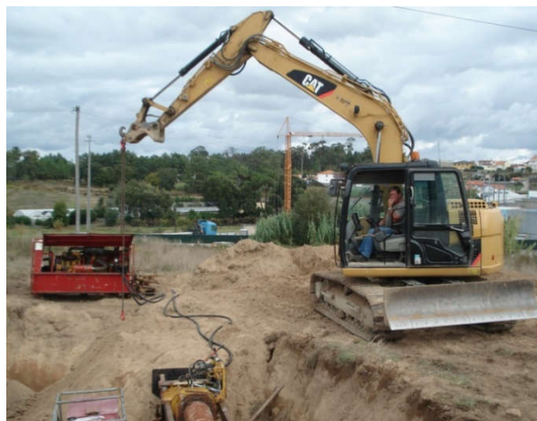
Figura 47 - Montagem do equipamento de perfuração recorrendo a escavadora no poço previamente escavado
