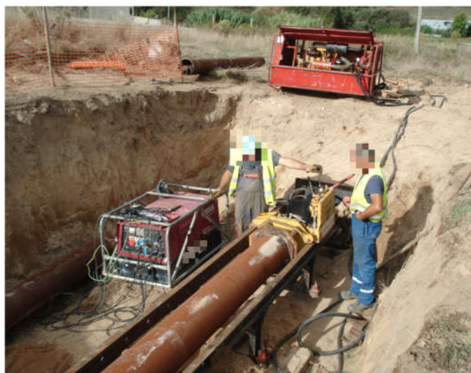
Figura 51 - Vista geral do poço de ataque
