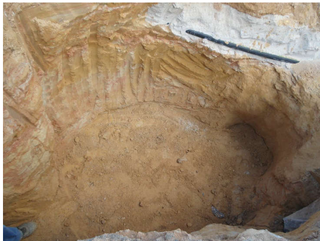
Figura 28 - Escavação devidamente nivelada com agregado para colocação de fundo de caixa de visita
