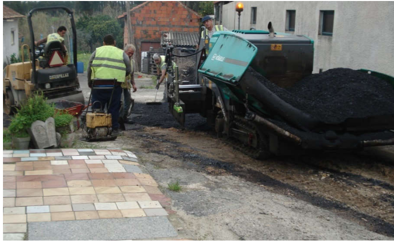
Figura 43 - Espalhamento e compactação da camada de binder betuminoso
