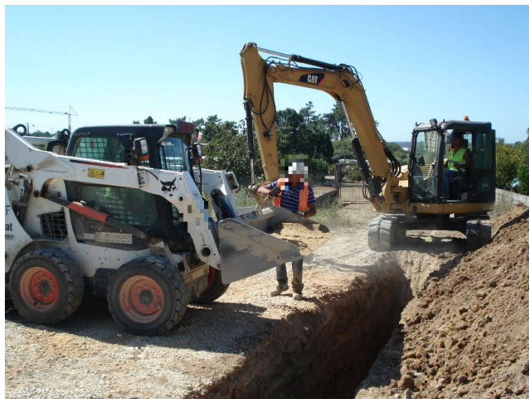
Figura 22 - Aterro de vala com areia
