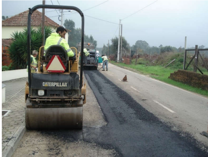
Figura 45 - Espalhamento e compactação da camada de desgaste
