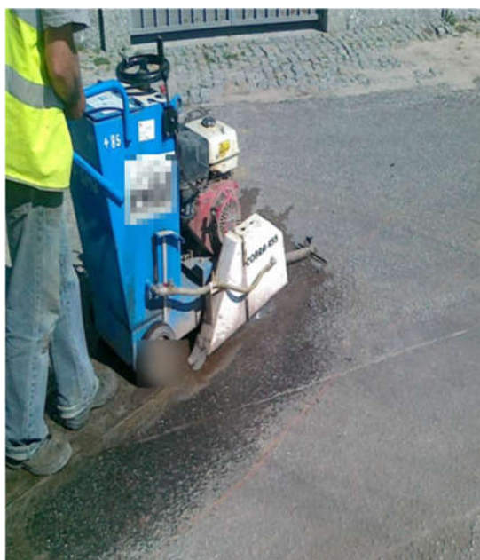
Figura 16 - Corte de pavimento
