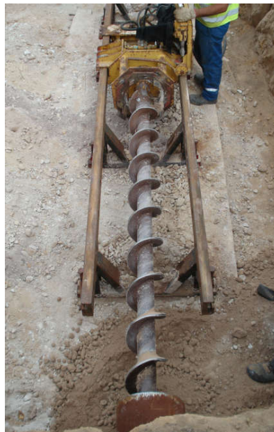
Figura 49 - Perfuração com trados mecânicos a retirarem o solo
