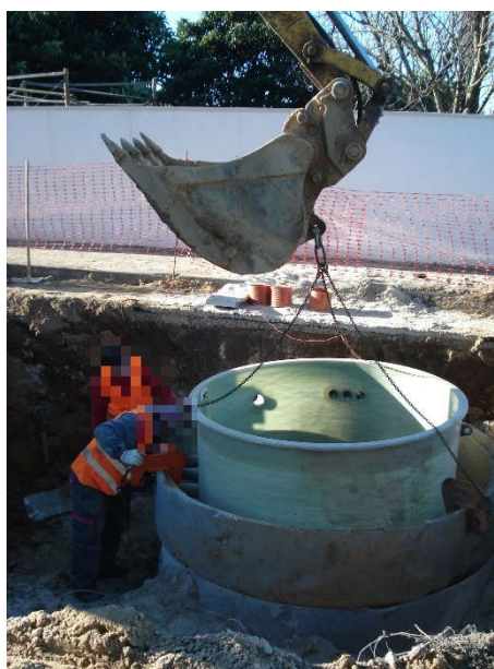
Figura 55 - Colocação de poço em PRFV
