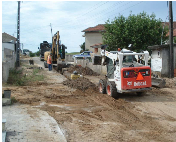
Figura 19 - Execução de escavação (abertura de vala)
