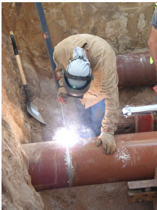
Figura 50 - Soldadura dos tubos de encamisamento
