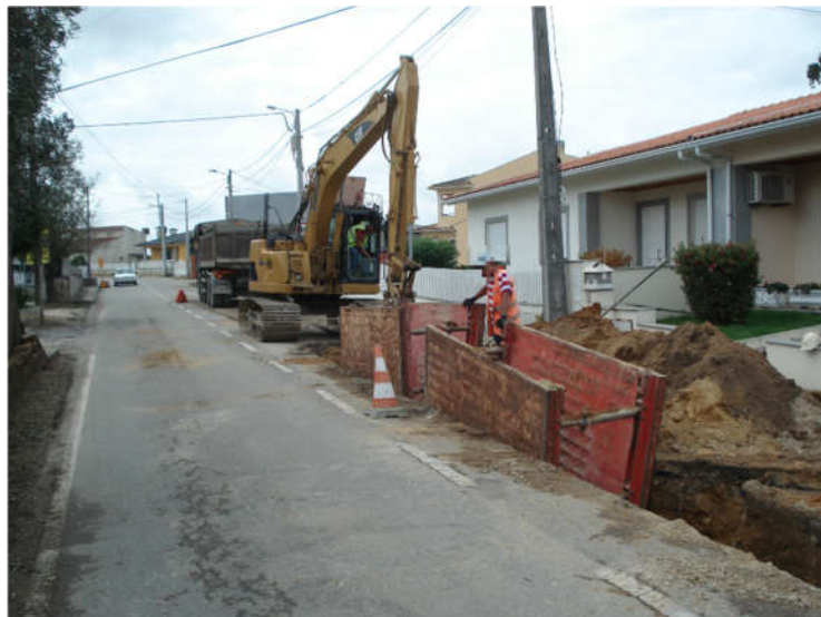
Figura 20 - Aplicação de entivação em vala
