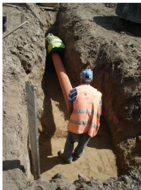
Figura 26 - Encaixe de dois troços de tubagem do coletor gravítico de águas residuais
