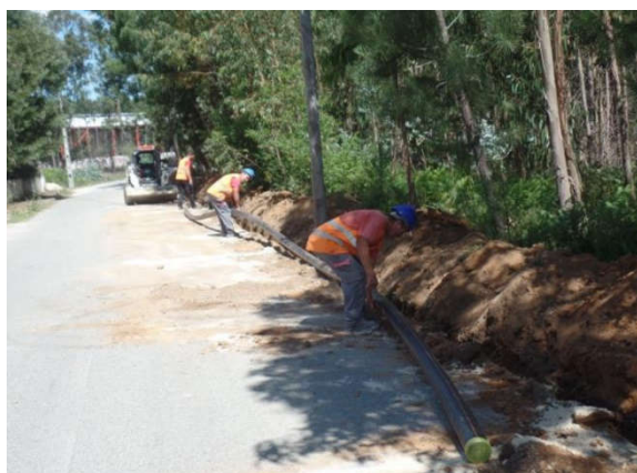
Figura 24 - Tubagem de polietileno colocada ao longo da vala a fim de ser soldada
