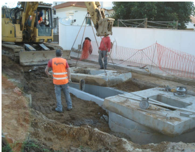
Figura 58 - Lajes pré-fabricadas a serem instaladas sobre poço e câmara de manobras
