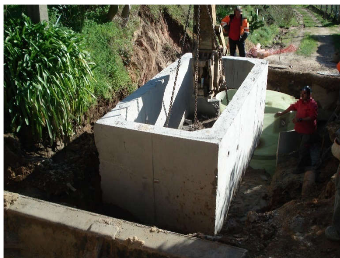
Figura 57 - Colocação de câmara de manobras pré-fabricada
