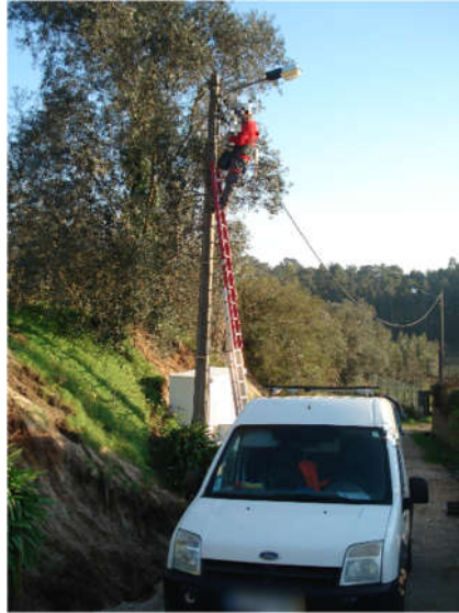
Figura 66 - Execução de ramal de ligação à rede
