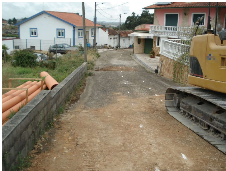
Figura 15 - Marcação do pavimento antes do corte
