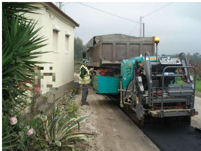
Figura 44 - Execução de camada de desgaste com recurso a espalhadora
