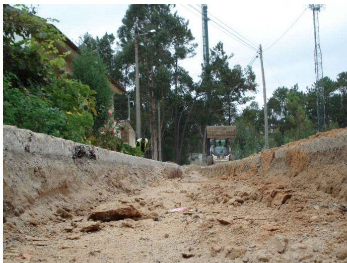
Figura 38 - Aterro de vala recorrendo a mini pá carregadora
