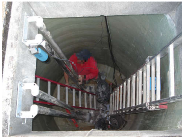
Figura 61 - Instalação de suportes e guias para grupo eletrobomba
