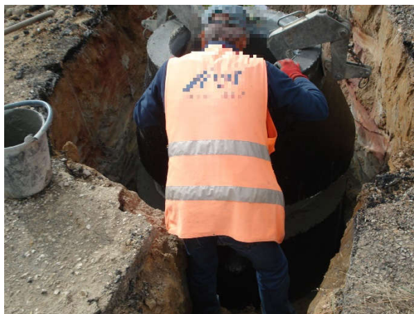
Figura 31 - Colocação do cone pré-fabricado de betão da câmara de visita
