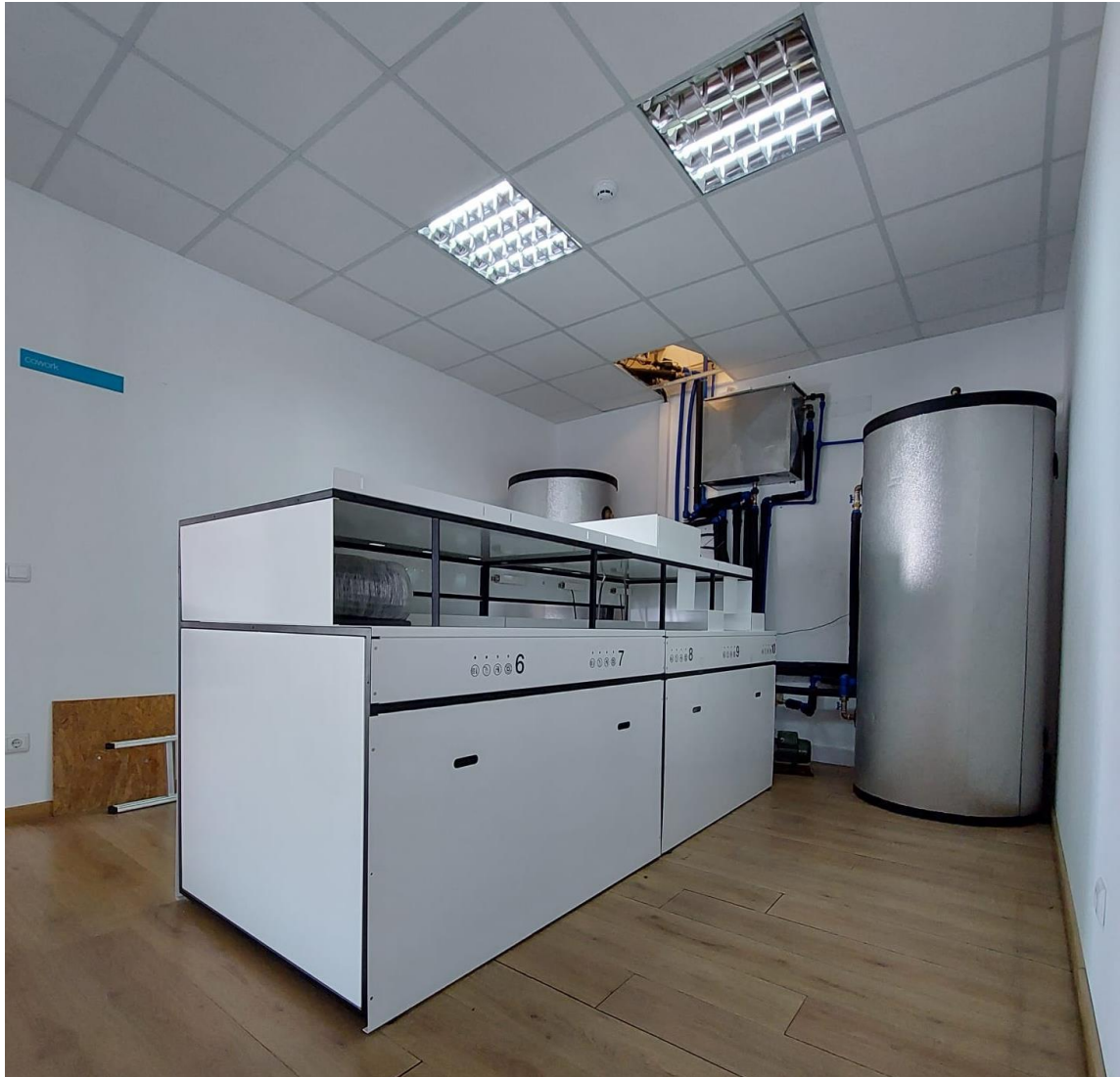
Figura 44 - Instalação final da bancada de ensaio
