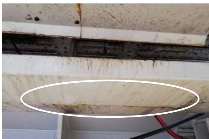
Figura E.2- Fotografia ilustrativa de condensados de óleo formados no equipamento.
