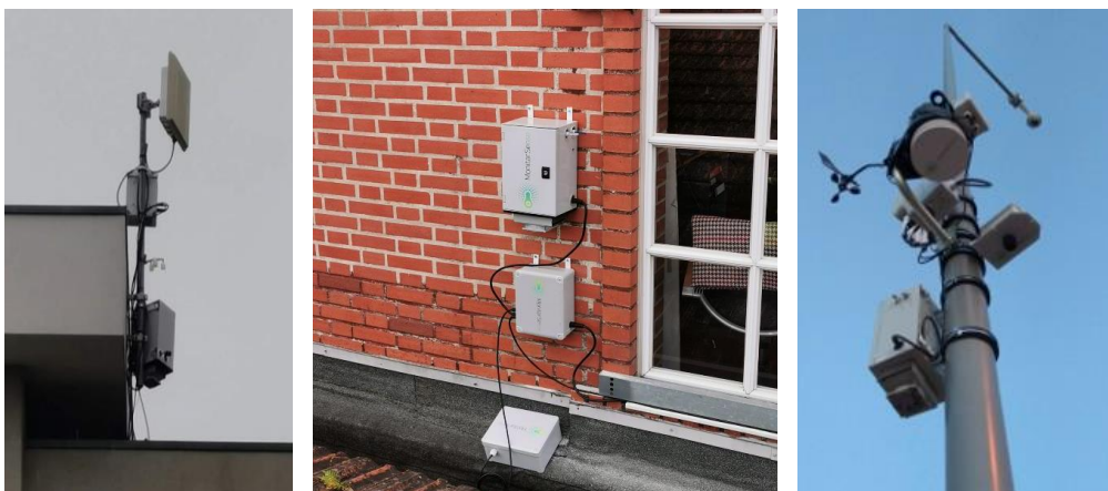
Figura 21 - Estações de monitorização da qualidade do ar no Edifício da Antiga Reitoria (esquerda), Centro de Congressos (centro), e uma estação meteorológica (direita).
