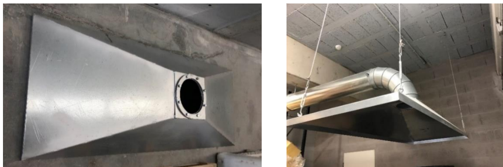
Figura 7.16 – Exaustor produzido e montado na sala de preparação de moldes para conformação por enchimento sob pressão.
