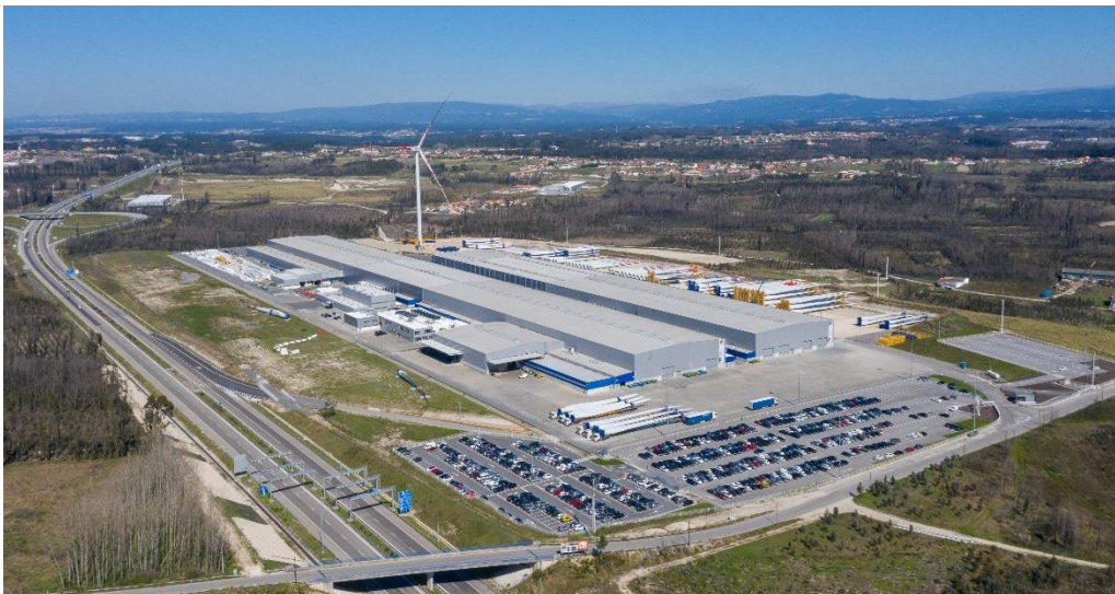
Figura 5 - Instalações da Siemens Gamesa Renewbale Energy Blades S.A.
