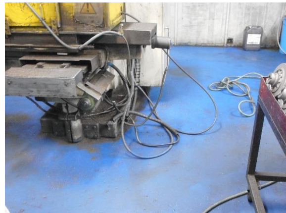
Figura 19 - Mangueira no chão
