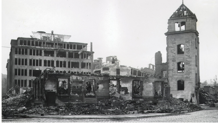
Figura 1.5: Estrutura da primeira fábrica da Bosch gravemente danificada, em 1945, após bombardeamento dos Aliados.
