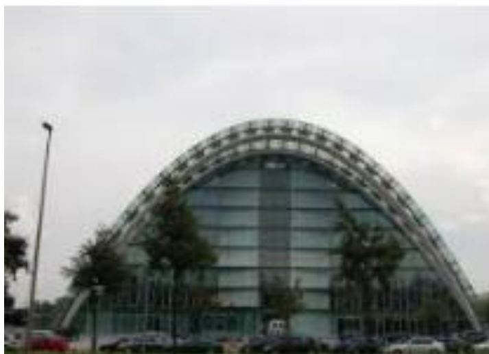
Figura 59 - Edifício berliner bogen, em Hamburgo (Fonte: https://files.structurae.net/files/photos/2445/dsc_1133.jpg )
