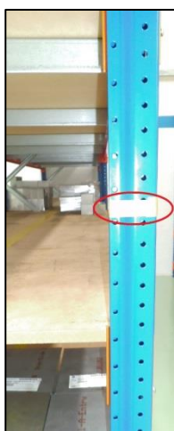
Figura 23 – Marcação do limite em altura por prateleira nas estantes de carga ligeira
