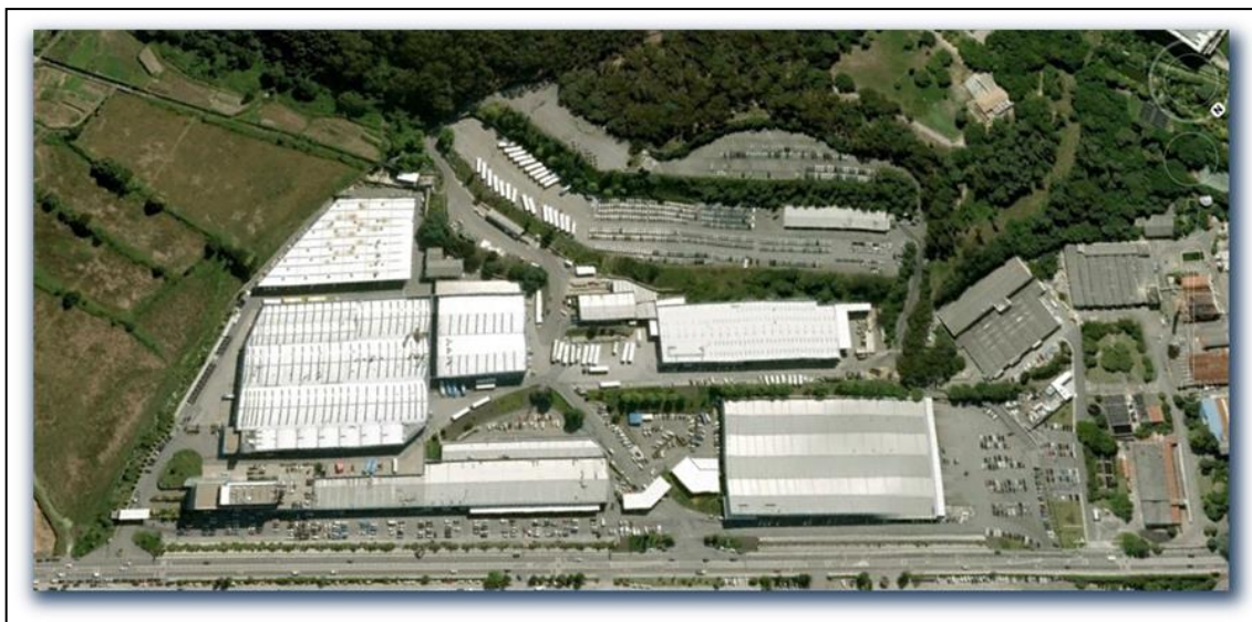
Figura 13 – Vista aérea do Grupo Salvador Caetano S.A.
