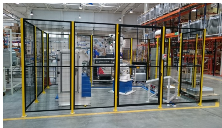
(a) Equipamento de proteção mecânico.
