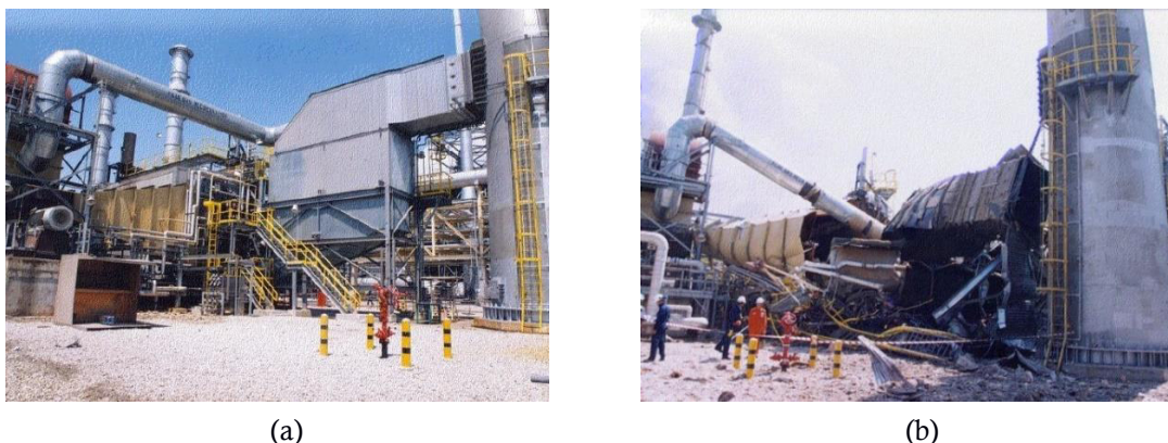
Figura 1 – Caldeira da Exxon Mobil em Singapura antes da explosão (a) depois da explosão (b) [5]
