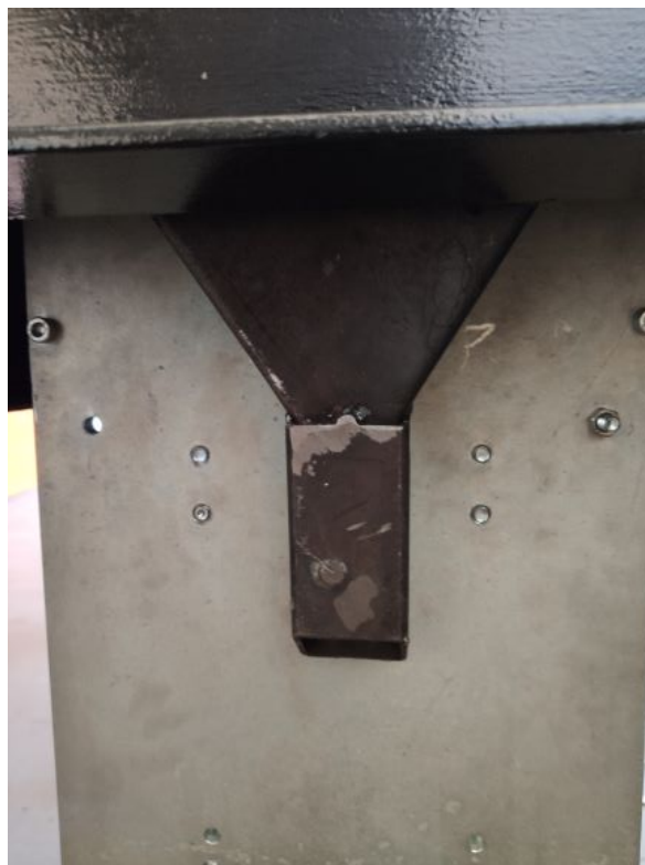
Figura 6.16: Conduto fabricada em posição
