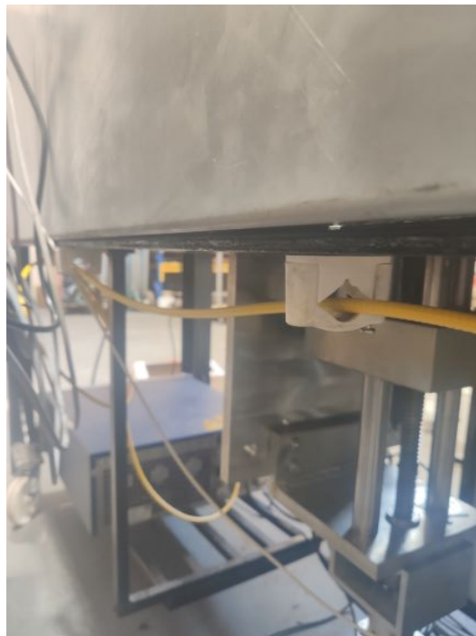
Figura 6.23: Percurso da fibra ótica na parte inferior da estrutura da máquina
