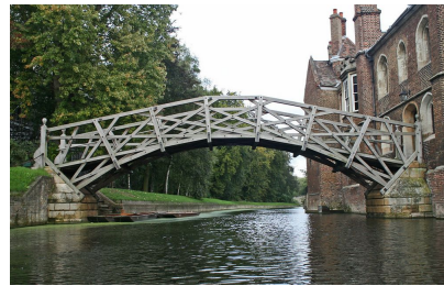
Figura 2.9: Ponte de da Vinci, das primeiras estruturas auto-portantes
