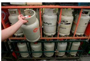
Figura 3.1: Armazenamento de garrafas de gás tradicional
